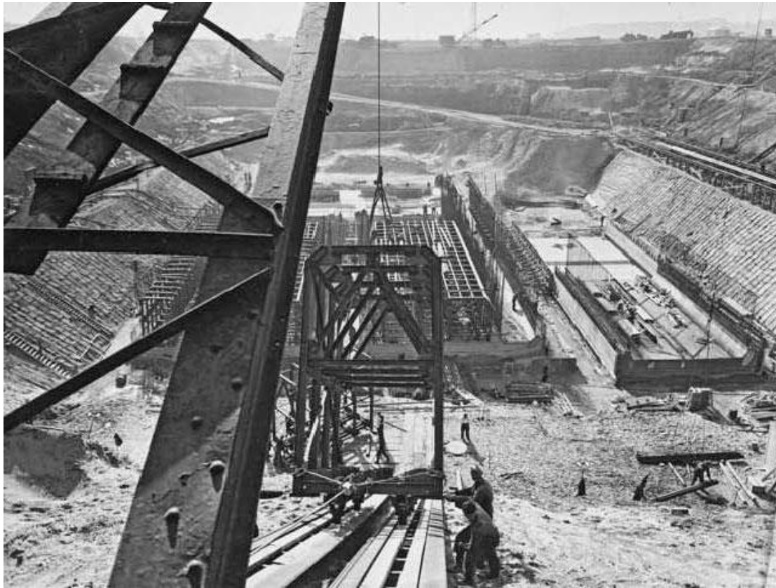
Aanleg Velsertunnel 1954 (Amsterdam)
